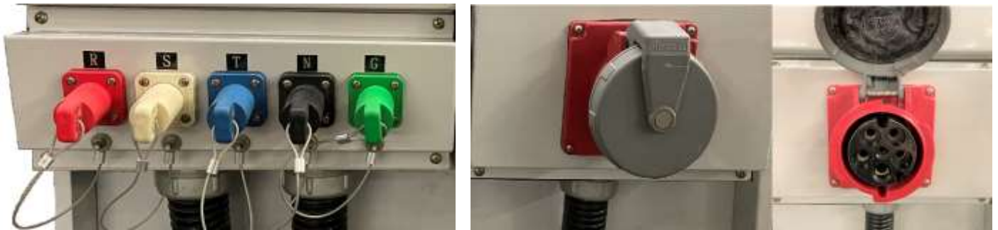
圖例 3.7.1- 外接電源 Camlock、CEE 125 圖示
