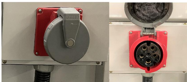
圖例 3.6- 外接電源 Camlock、CEE125 圖示
