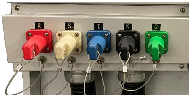
圖例 3.6- 外接電源 Camlock、CEE125 圖示
